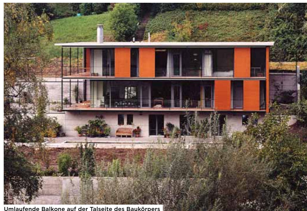
Umlaufende Balkone auf der Talseite des Baukörpers
