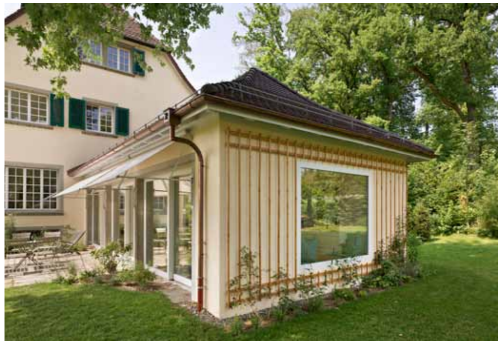
ANBAU DOPPELHAUS HOCHWACHTSTRASSE 24A, 8400 WINTERTHUR Bauherrschaft: Privat Ausführung: 2010 bis 2011 Bilder: Thomas Aus der Au
