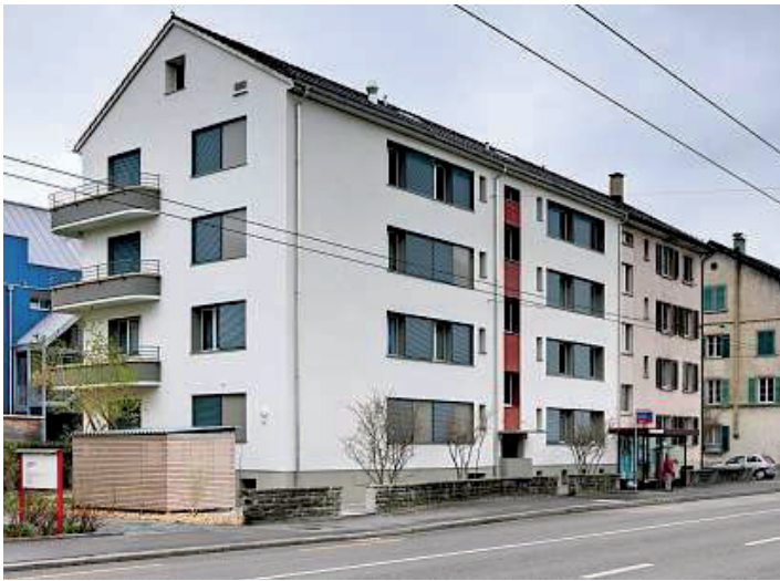
Markiert starke Präsenz nach der Renovation – das Mehrfamilienhaus an der Tösstalstrasse 82 im Besitz der Stadt Winterthur.
