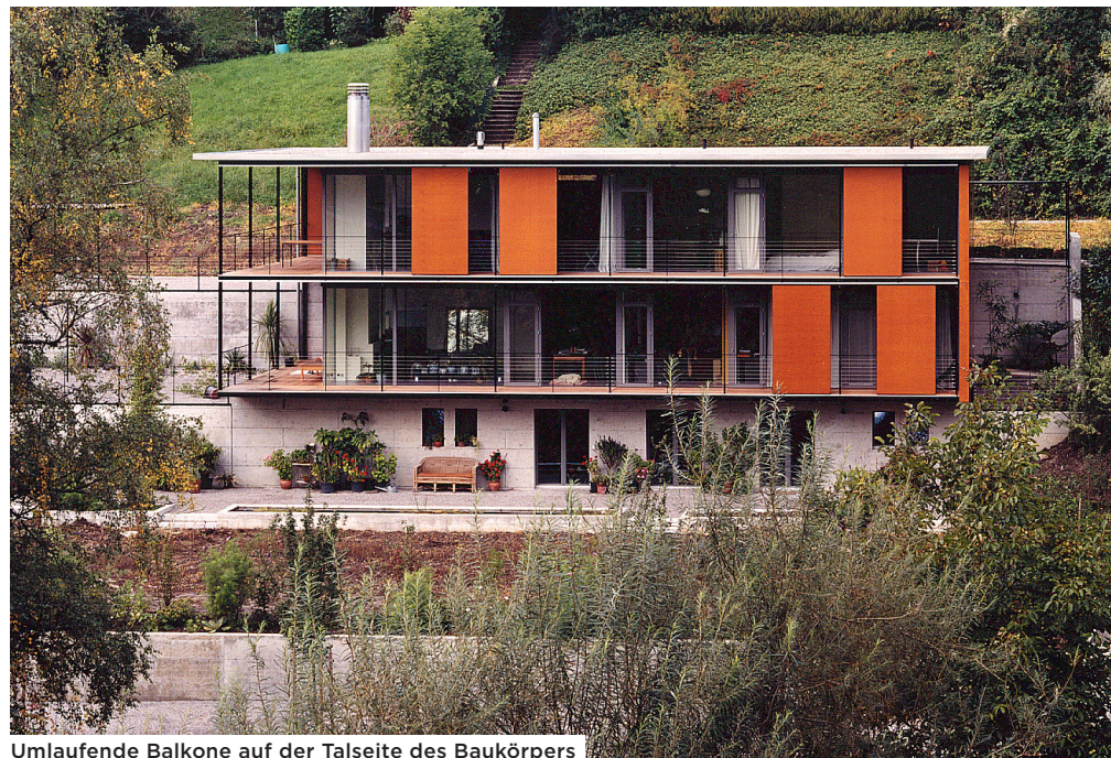
Umlaufende Balkone auf der Talseite des Baukörpers
