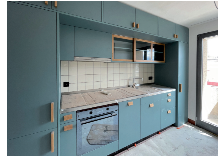
Küche Zürcherstrasse | kurz vor Fertigstellung 2023
