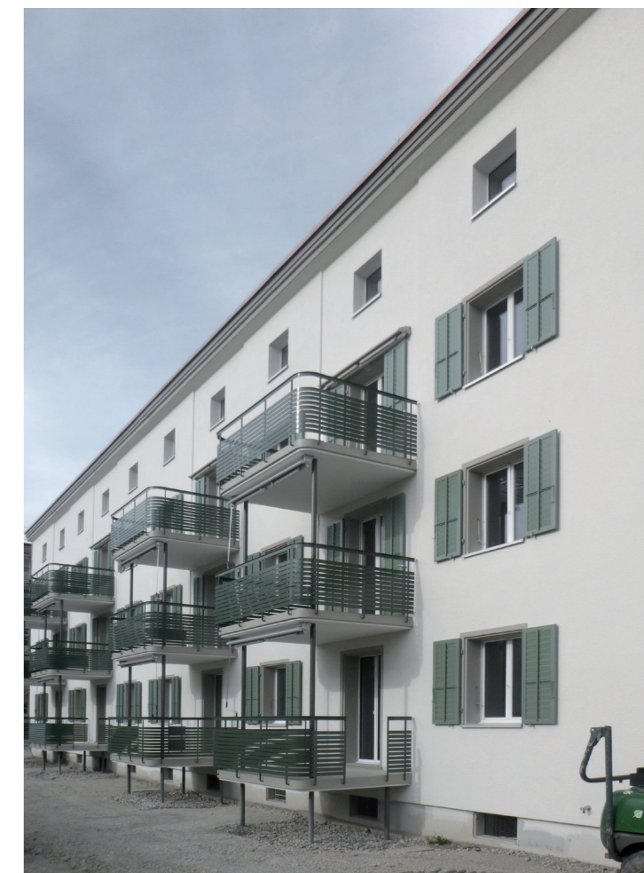
Gartenfassade Obere Schöntalstrasse | kurz vor Fertigstellung 2023
