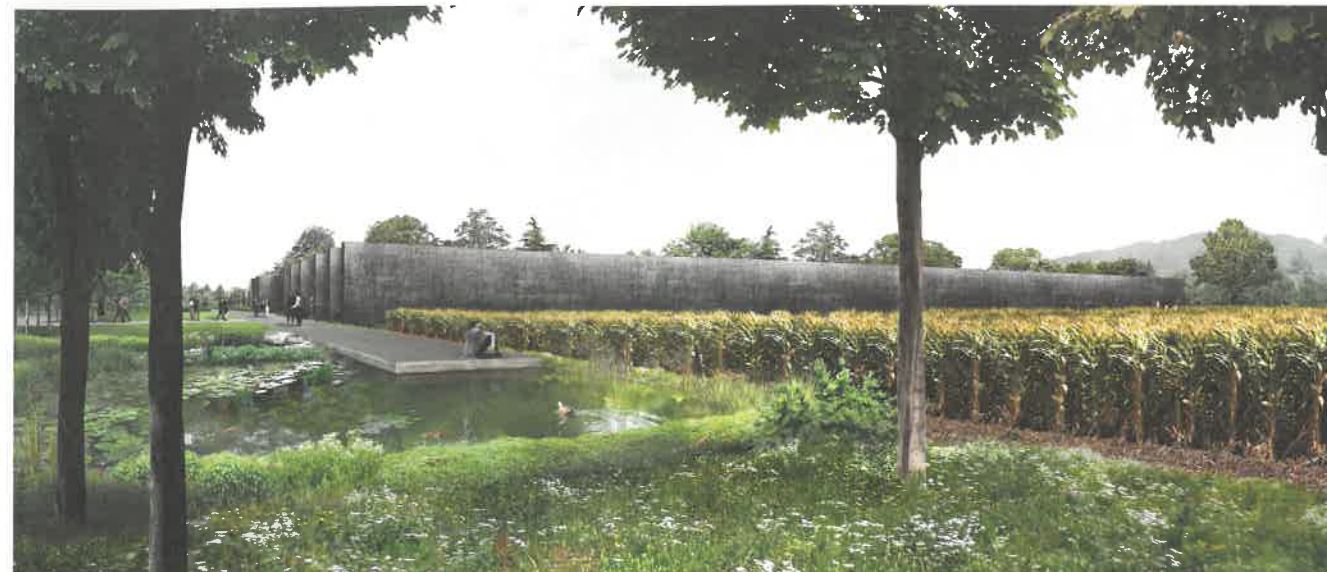
Das Krematorium ist aus sechs parallelen Mauern gebaut.
