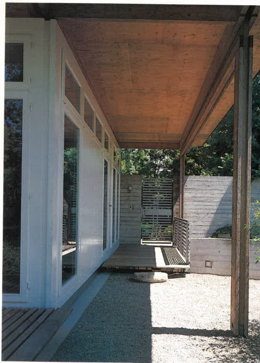
Sehr schön: Eingangstür und Brüstungsgeländer aus feuerverzinktem Flacheisen
