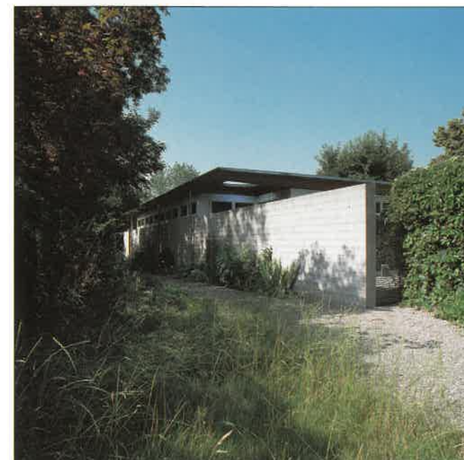
Eine Betonscheibe bildet den Rücken des Pavillons und schirmt ihn gegen die Erschliessungsseite ab. ▲
