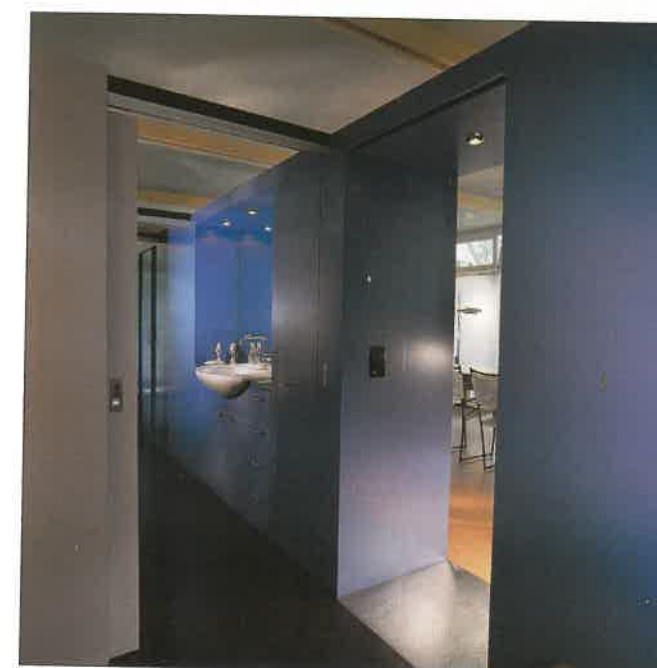
Die Öffnungen im Schrankelement, die mit Schiebetüren verschlossen werden können, dienen als Durchgänge zwischen vorderem Wohn- und hinterem Schlaf- und Badbereich. ▲
