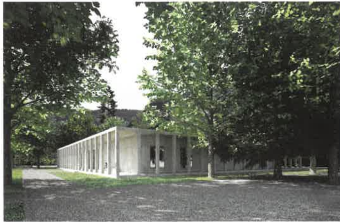
Ansicht des Portikus des Krematoriums
